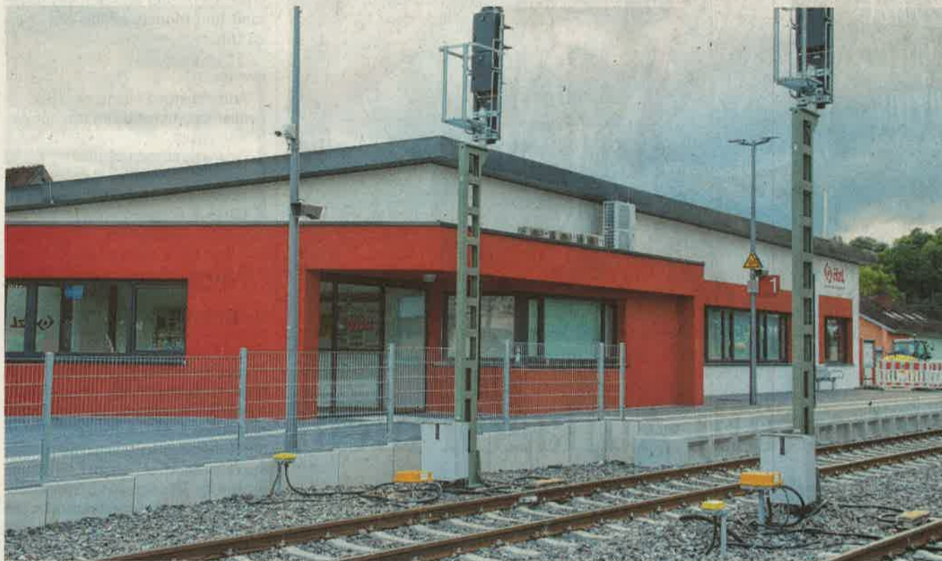
Das Stadtbild von Gammertingen wurde ebenfalls mit dem Bau aufgewertet.
