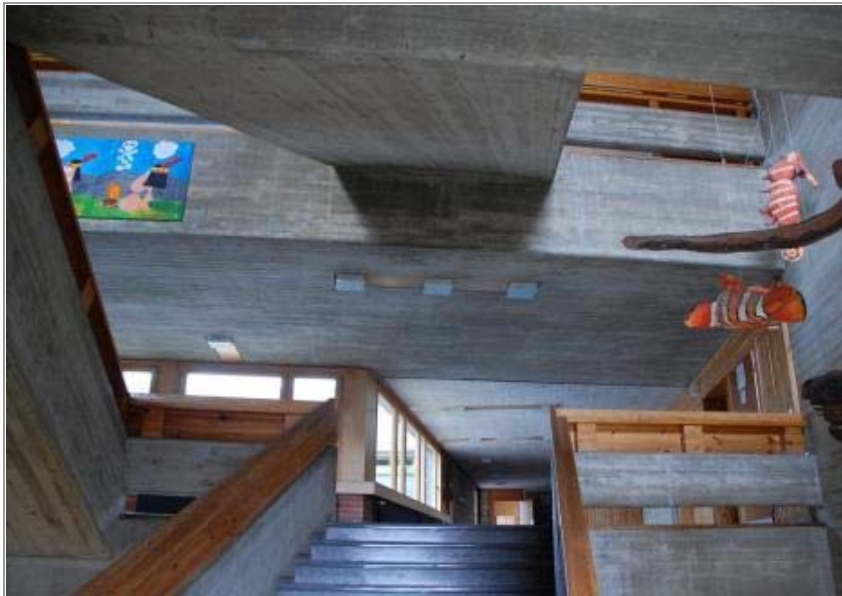
Das Gammertinger Gymnasium ist in die Jahre gekommen und soll in den nächsten Sommerferien saniert werden. FOTO: HÄUSSLER
