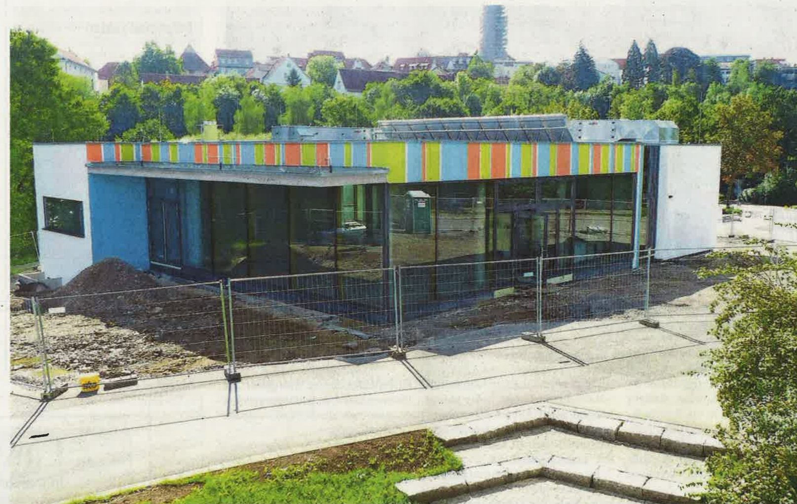
Der weiß verputzte Mensaneubau hat teilweise eine farbige Fassadengestaltung. Die bodentiefen Fenster garantieren den guten Blick nach draußen. FOTOS: STADT HECHINGEN
